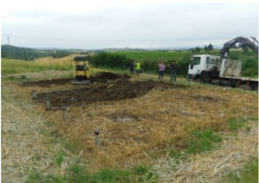
Curage de filtres à sable plantés de roseaux
