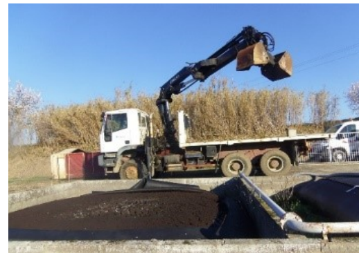
Curage d'un géotube
