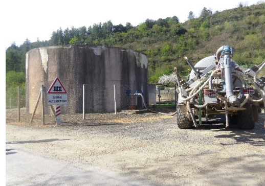
Pompage d'un silo de stockage
